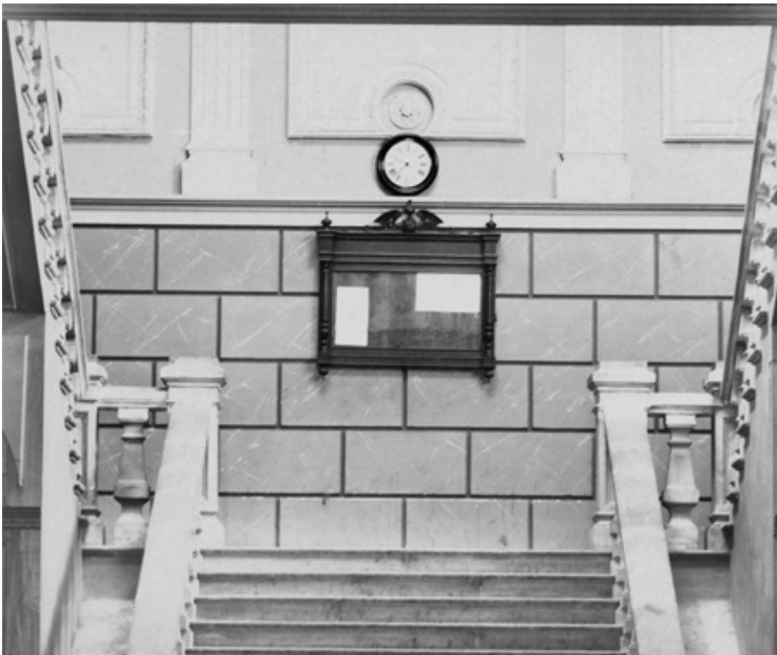
Ilustración 2: Foto de la escalera principal antes del cambio de la balastrada de piedra
